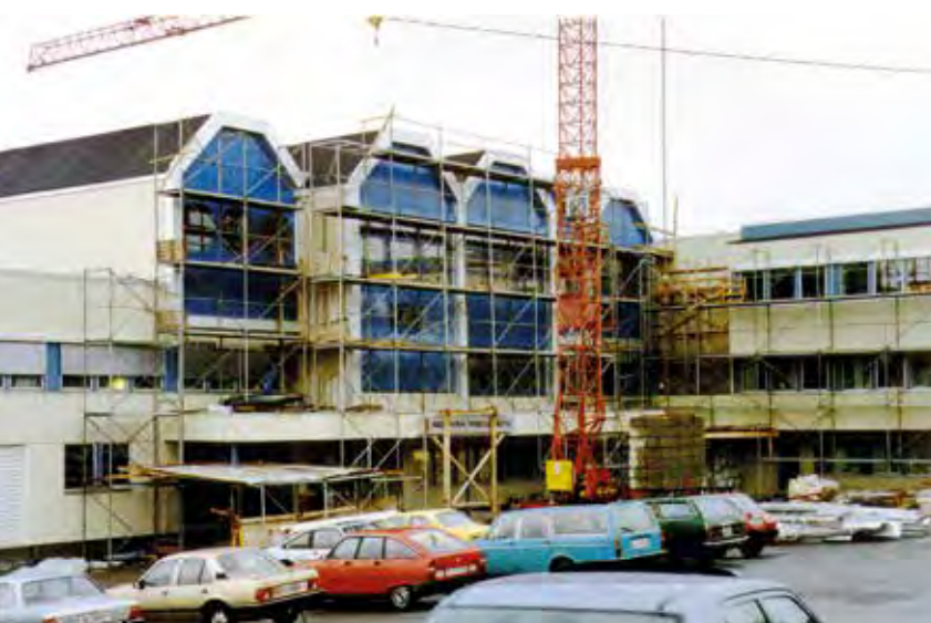
Toppen på A-blokka med kantine og toppen på B-blokka (tverrfløya) ble tatt i bruk 1. desember 1989.
